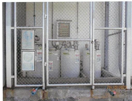
ภาพที่ 2.2-21 พื้นที่เก็บสารเคมีที่ใช้บำบัดน้ำใช้ของ ศูนย์ขนส่งทางอากาศของบริษัทฯ
