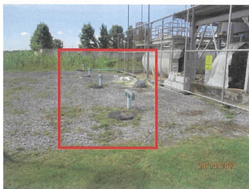
ภาพที่ 2.1-8 ถังเก็บรวบรวมน้ำเสียจากการล้างเฮลิคอปเตอร์ (ถังใต้ดิน) ในกรณีที่ระบบบำบัดน้ำเสียไม่สามารถทำงานได้
